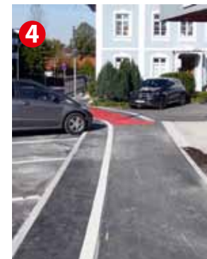
3 Diese Bordsteinkante soll laut Verwaltung noch „auf Null“ abgeschliffen werden.
